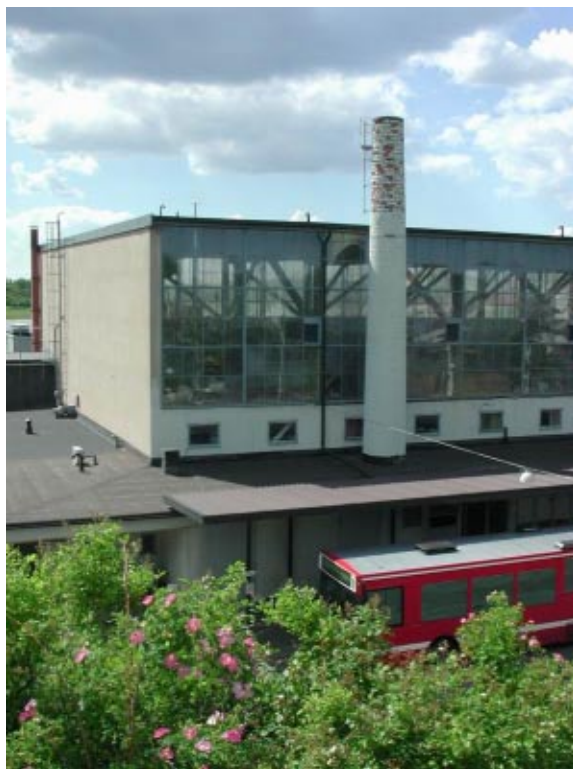
Hangarens sydöstra hörn år 2001 med ursprunglig skorsten från värmecentral i lågdelen.
