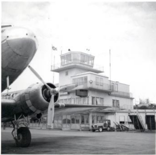
Stationsbyggnaden år 1949 då den nyligen försetts med nytt torn, utökad takvåning och flera andra tillägg. Bromma flygplats arkiv
