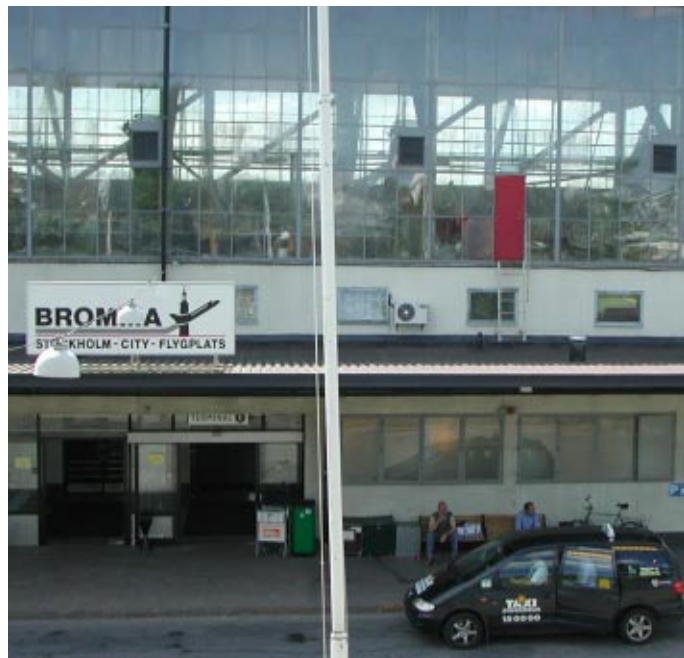
Terminalbyggnaden / hangar A som den ser ut idag från gatusidan. Byggnadens intressanta takkonstruktion syns genom glasfasaden.
