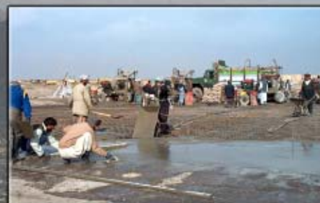
Reparation av banan på Kabuls flygplats
